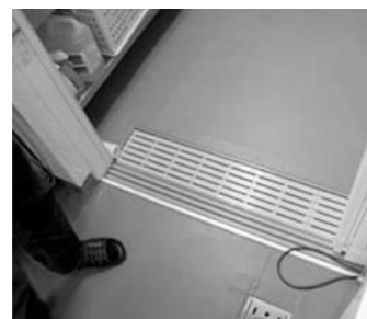
作業室仕切りの排水溝
